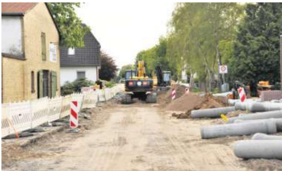
Die Schacht- und Leitungssanierung im Abwassersystem der Stolker Straße soll bald abgeschlossen sein.
