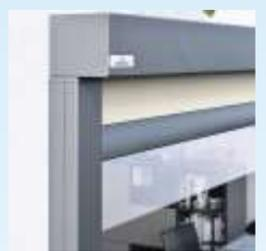
und Klima hinter der Markise beeinflussen. Es gibt Tücher ohne Durchsicht, aber auch welche mit geringerer oder höherer Transparenz. Außerdem sind Stoffe wählbar, die mit regelmäßig angeordneten Durchbrechungen oder vielen kleinen Poren luftdurchlässig sind und so für einen stetigen Luftaustausch im Sommer sorgen.
